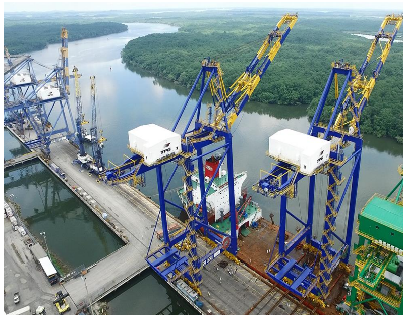
Figura 2. Terminal Portuario de Guayaquil Fuente: Galería del Terminal Portuario Guayaquil TPG
