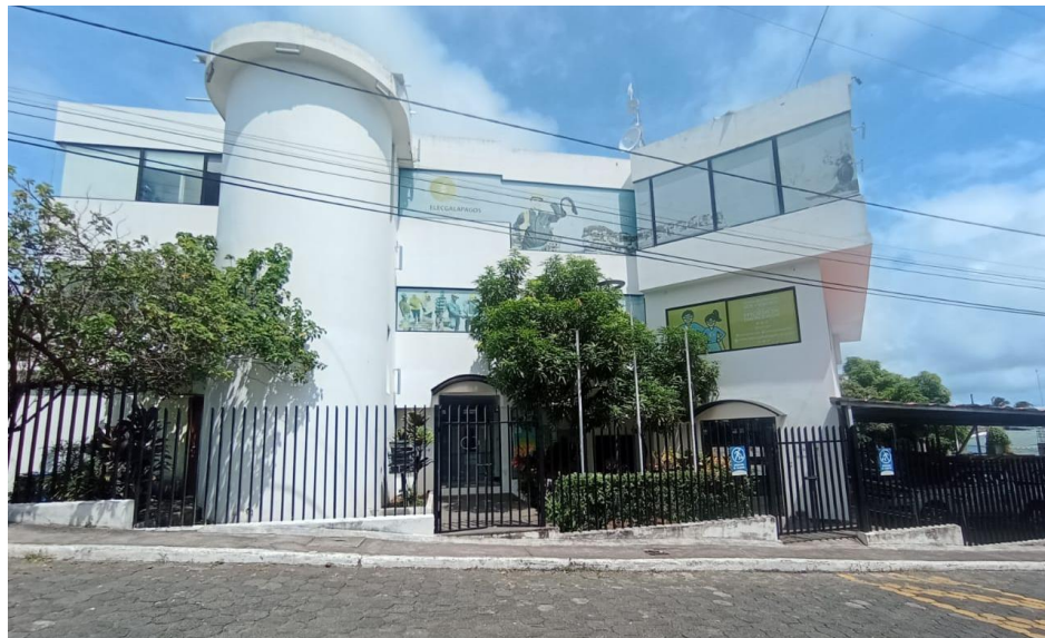
Figura 4.1: Instalaciones de ELECGALAPAGOS
