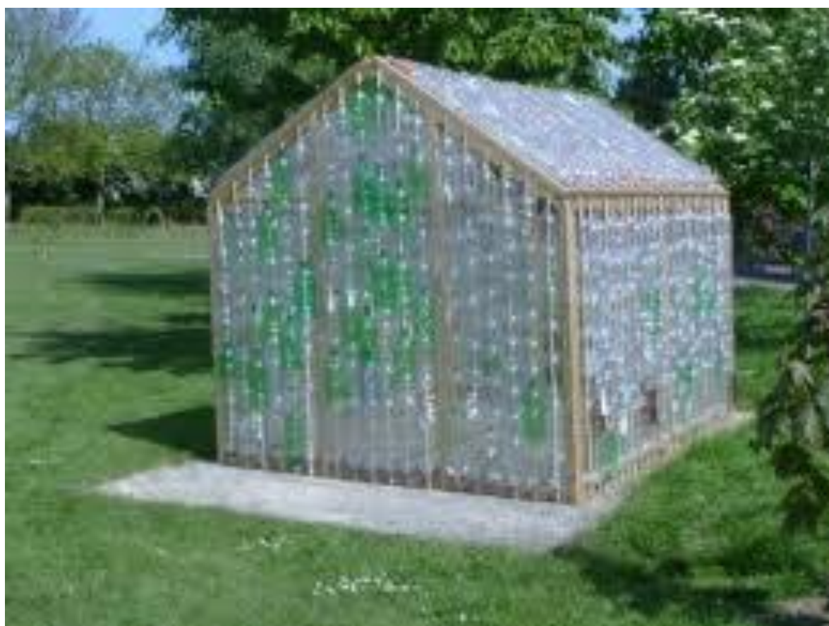
Gráfico No. 3. 7: La casa hecha con reciclaje de botellas de plástico.
